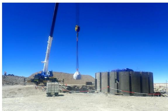
図 2.2: (左) 仮組した観測運用棟の構造体, (右) 山頂にて組み上げられた望遠鏡ピア用プレキャストブロック.
